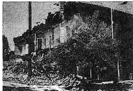
写真-2 レンガ造商店の被害状況 (コーリンガ)
