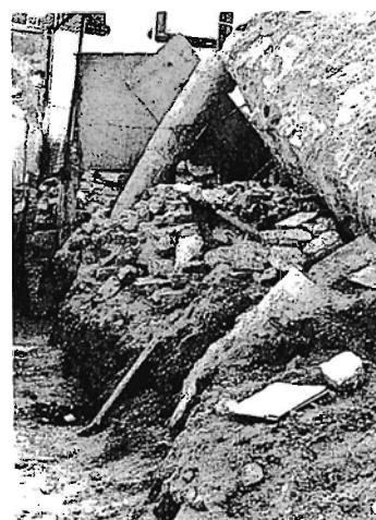
写真1 転倒した共同住宅の基礎露出
