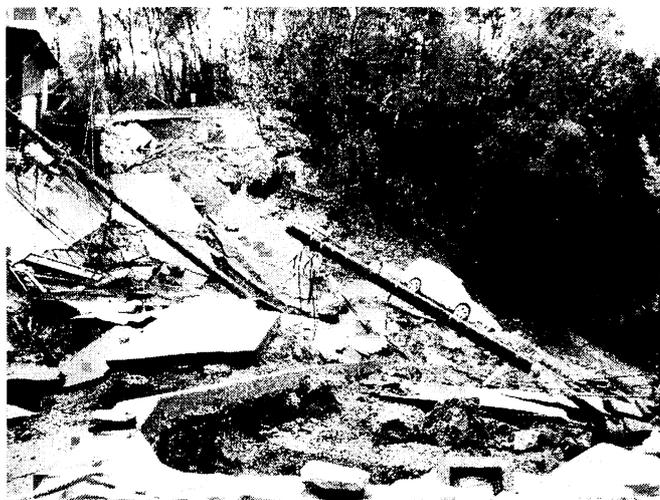
写真4 長岡市高岡地区の造成地での地すべり被害(図3)
