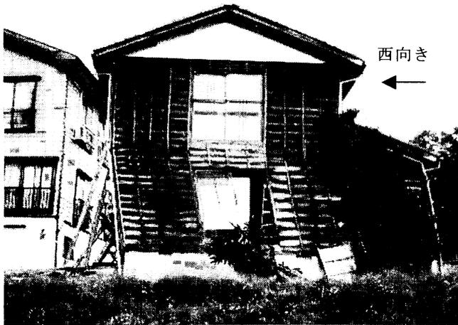
写真1 西向きに傾斜した建物（竜光）
