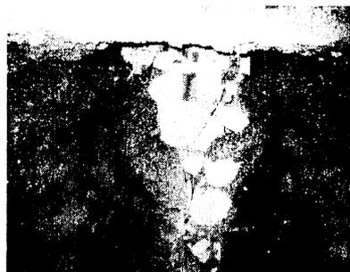
写真 1 校舎棟の北東隅杭(No.1 杭)の被害状況
