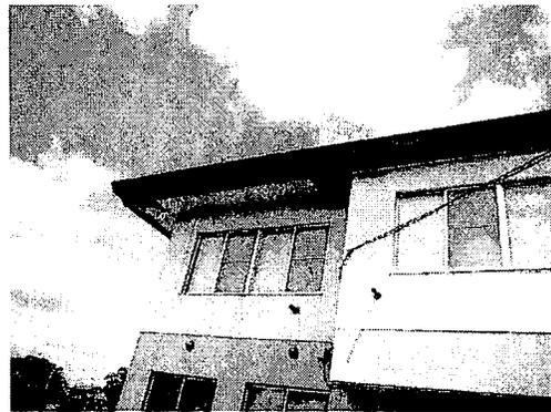
写真 20 屋根の裏の板の落下 (奥州市衣川区震度計)
