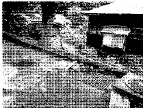
写真30 洋野町大野震度計の横の段差
