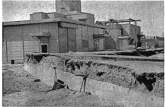
写真 3.5 共同溝の浮き上がり
