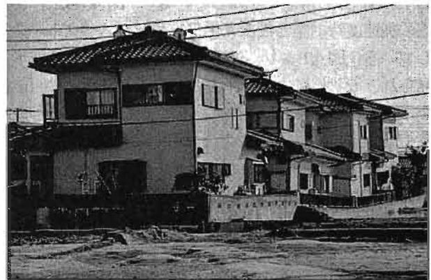
写真 3.7 盛土中央部で沈下大
