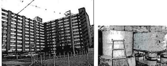
写真4 基礎の補強効果により構造被害が無かった仙台市太白区の市営住宅
