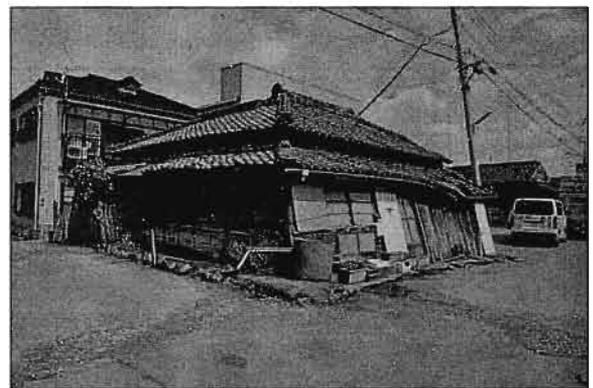
写真 3.2 側方流動により生じた建物被害
