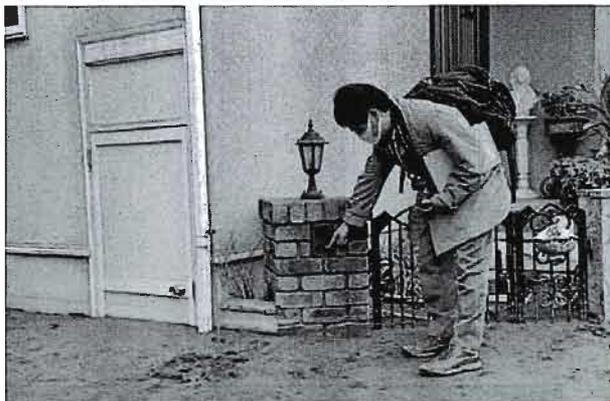
写真 2.2 大きく沈下した建物
