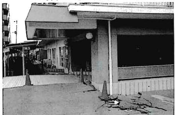
写真 4.2 杭基礎建物の沈下
