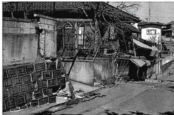
写真 4.3 擁壁の破壊
