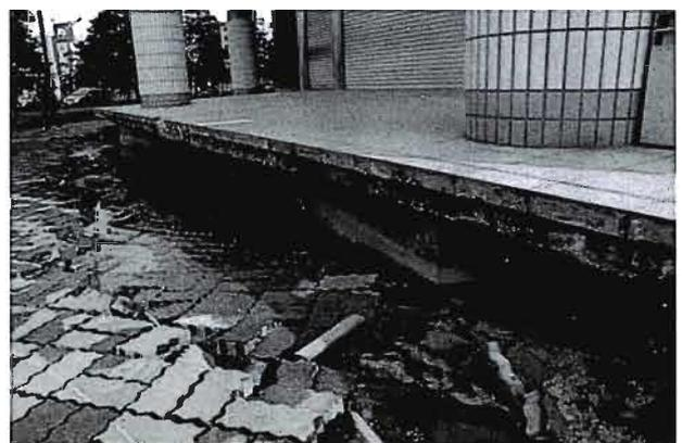
写真 2.5 杭基礎建物周辺の地盤沈下
