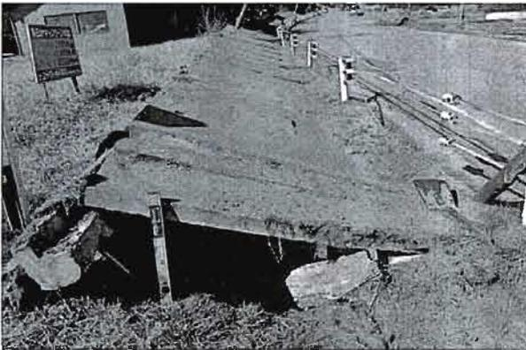
写真 3.4 液状化による歩道の被害
