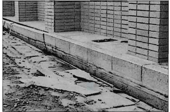
写真 4.17 隣接建物の周辺地盤の沈下
