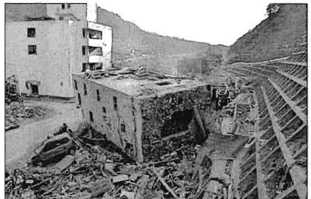
写真 4.13 70m 流され転倒した建物 B
