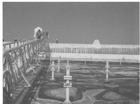
図 10 浮屋根上への油の流出（消防研究センター撮影）
