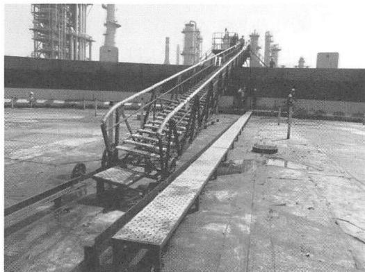
図 1 ローリングラダーの脱輪（消防研究センター撮影）
