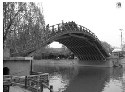
図 4 開封市が再建した RC 造虹橋
