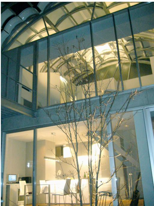
この住宅の屋根架構は、フラクタル幾何学に基づく樹形と同じ形態システムを持っている。積層状に分岐するアーチは、適度な屋根面の凹凸を形成し、風の抗力と揚力をバランスさせて風に強い構造を実現している。構造最適化の計算は行わず、形態の変化と風圧分布係数の関係を風洞実験により求めて、構造設計に利用している。フラクタルを用いた新しい構造形態とその力学的意味を明らかにした作品である。
