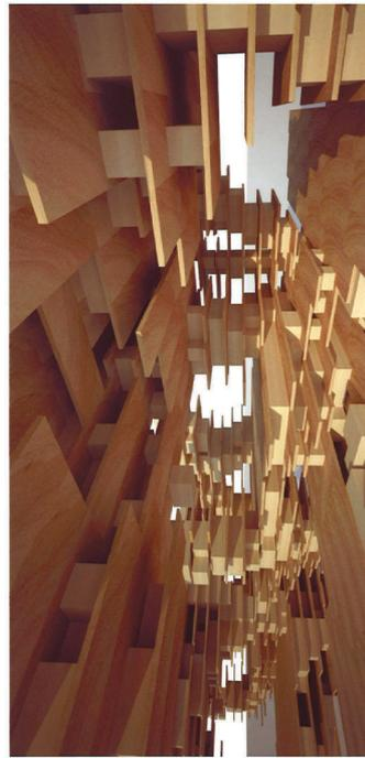
ねじや釘を使わずに状態で加工されたスライドのブロックの方式で構成する
