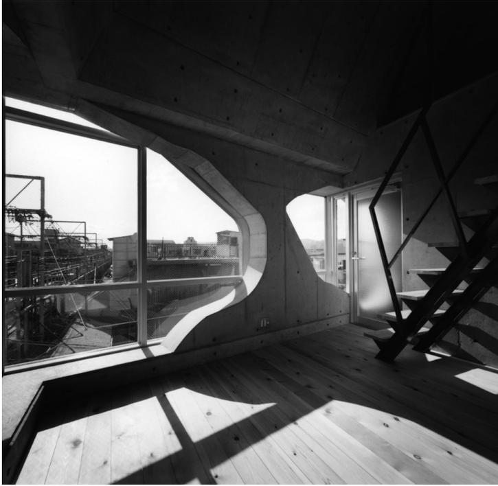
この建築は、拡張 ESO 法と呼ばれる方法で構造形態が創られている。具体的には、開口部の位置と大きさを設計者が初期値として指定し、自重と地震荷重に対して構造体の各部に生じる応力（ミーゼスの相当応力）を有限要素法で求め、指定した値より小さい場合その要素を取り除く。次に、等応力線を描き応力が大きくなると予測される部分に要素が加えられ、これを繰り返して構造形態を進化させ、最終的な形態を得ている。設計者の意匠的条件を満たしながら、古典的な構造形式に捉われず、新しい構造形態を創生した作品である。
