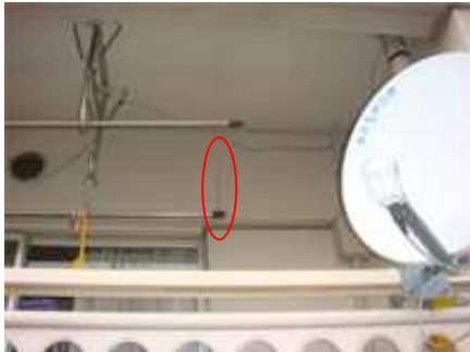
写真3 南面梁曲げひび割れ
