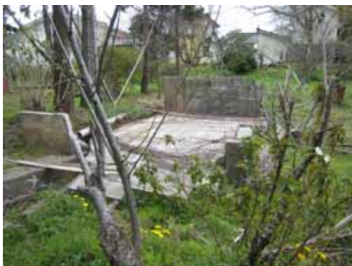
写真 5.1.2.7 調査番号 門 11 基礎ごと転倒した控壁付きブロック塀
