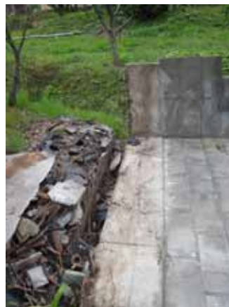
写真 5.1.2.7 調査番号 門 11 基礎ごと転倒した控壁付きブロック塀
