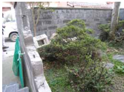
写真 5.1.1.5 調査番号 河 6 壁体端部、上 4 段が破壊・落下したブロック塀
