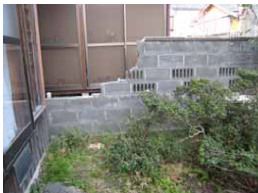
写真 5.1.1.5 調査番号 河 6 壁体端部、上 4 段が破壊・落下したブロック塀
