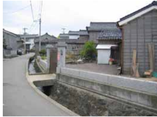
写真 5.2.3 調査番号 門3 下部一段を残し倒壊した 御影石塀
