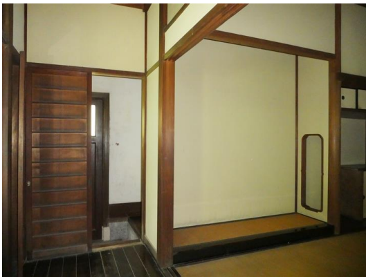
写真13 1階「御居間」と廻縁、脇玄関
