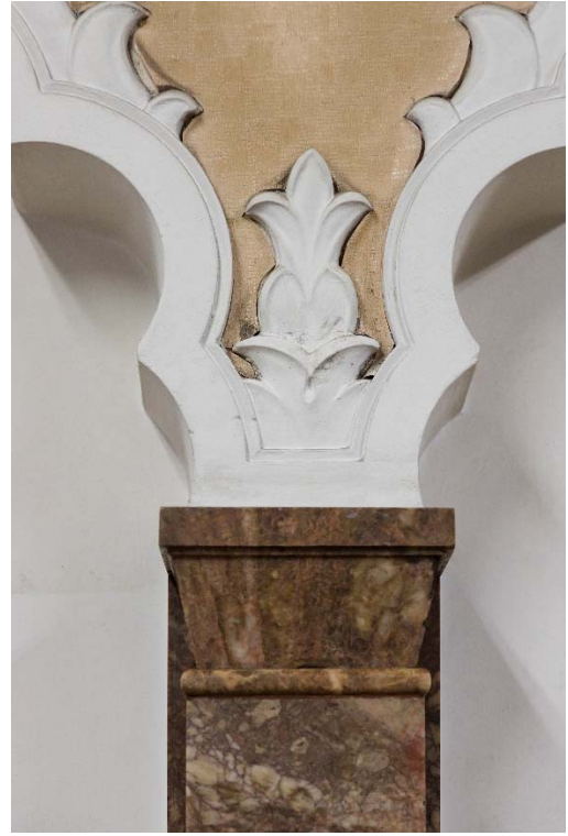
貴賓室マントルピース細部
