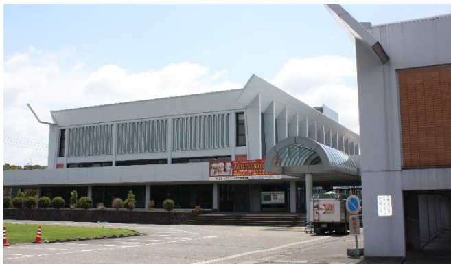
本館と別館（別館解体前）
