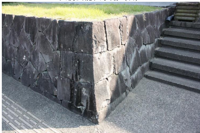
八代城本丸石垣を意識した基壇石積みの隅石
