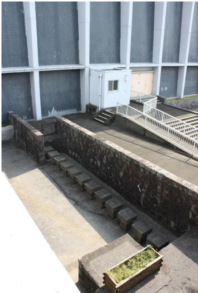
本館と別館の隙間、玄関ポーチの先にあった水盤は外堀の再現としての意義がある
