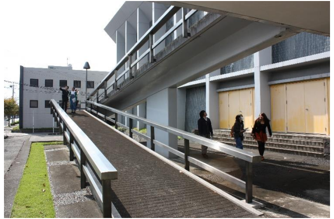
ピロティから2階テラスへ続くスロープ
