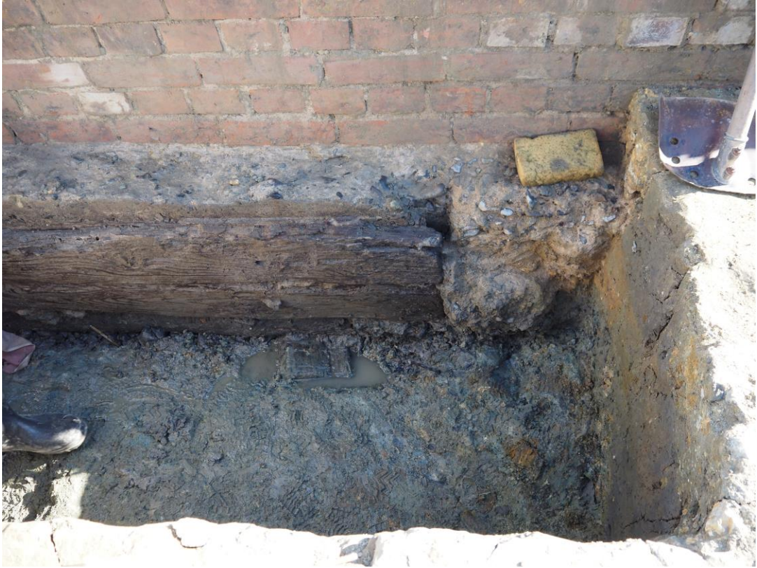
図3 北側機関車庫 埋め立て箇所の建物基礎工事
