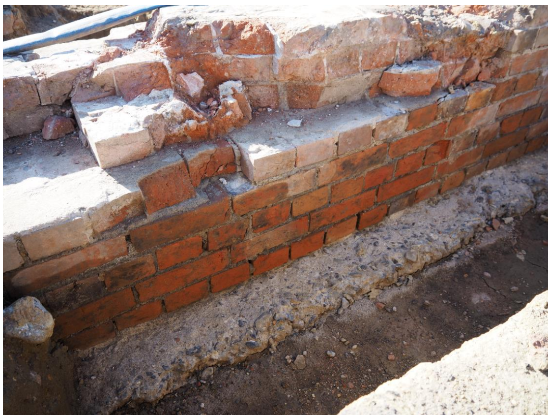
図2 北側機関車庫 地山上のコンクリート基礎、煉瓦壁体
