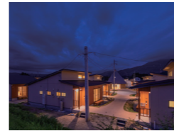
西原村買取型災害公営住宅 山西団地
