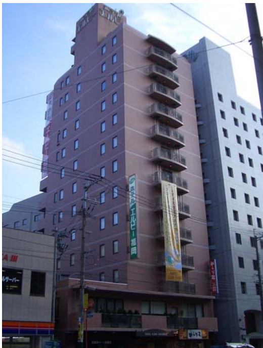
写真2.9 G建物の外観
