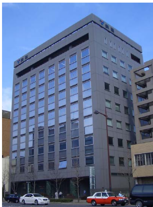
写真 2.1 D 建物の外観
