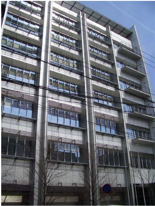
写真 2.3 C 建物の外観
