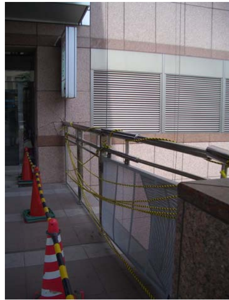
写真2.7 F建物のエキスパンションブリッジ
