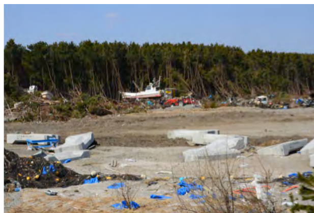
防潮林により堰き止められた漁船と瓦礫、津浪で破壊された防波堤を覆っていたコンクリートブロックが散乱している。
