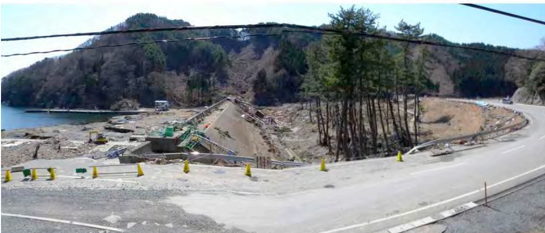
港湾部の防潮堤、堤内の松林、道路盛土による津波への対応
