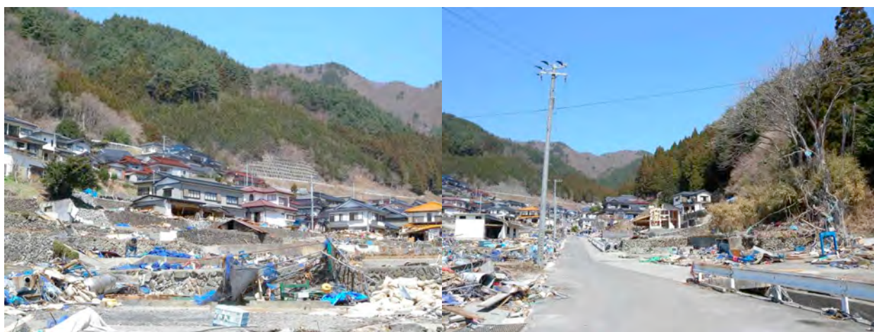
被災した沿岸部とその背後の斜面住宅
