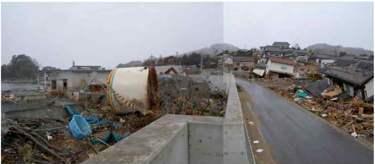
堤内の道路沿いと港湾部の被災状況 *北方向を撮影
