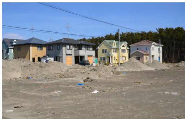
防潮林に近い新興住宅地の新築住宅は開口部からの浸水被害を受けた。
