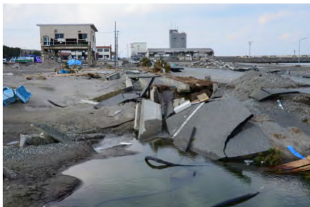
液状化による漁港地盤の崩壊
