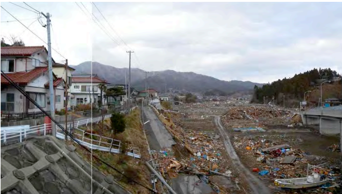
高所の住宅群と低地の被害の状況
