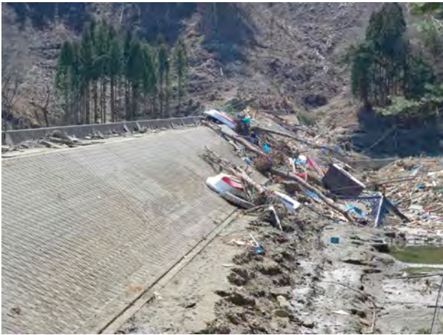
堤内の様子、船が入り込んでいる
