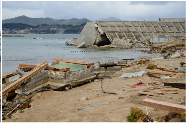
地震で液状化した地盤に防波堤を超えた津波の引き潮で流失した地盤と建物 (釜石市平田字尾崎白浜釜石湾漁港)
