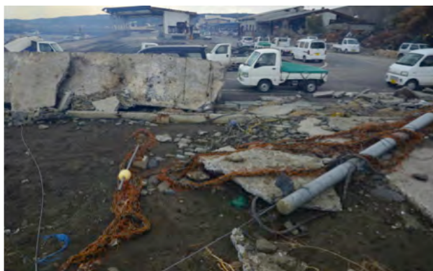
損壊した防波堤と漁市場
