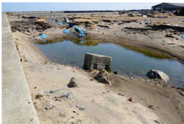
液状化した漁港と津浪により外壁が破損した漁港施設
