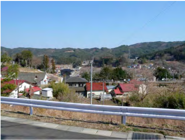
高所部分は健全 *鉄道駅より山手から撮影
