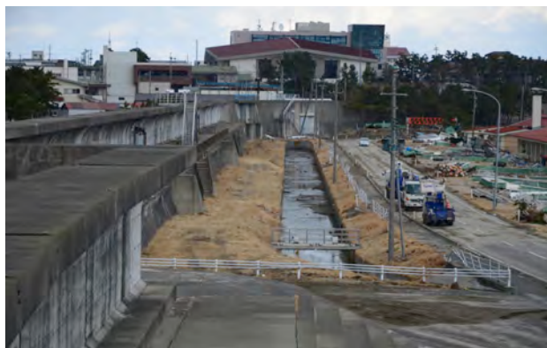
高さ 12 m の防潮堤に護られた洋野町種市市街
