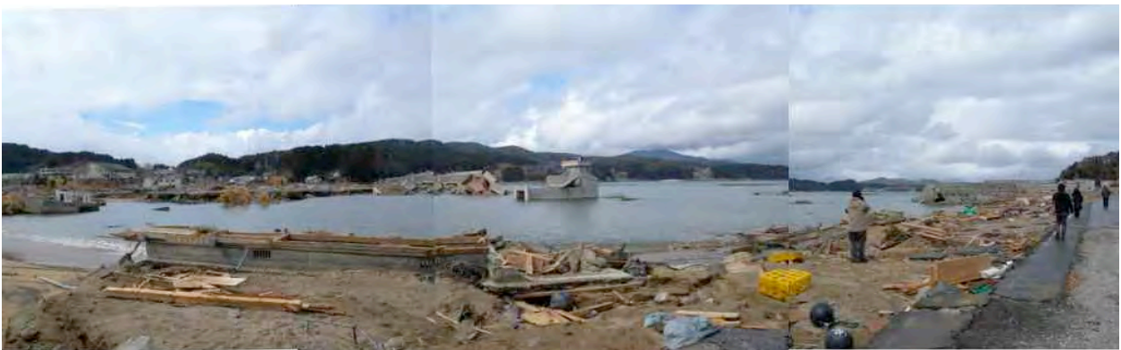
防潮堤が破堤し、堤内低地部は地形を含み大きく変化している *堤内を撮影
