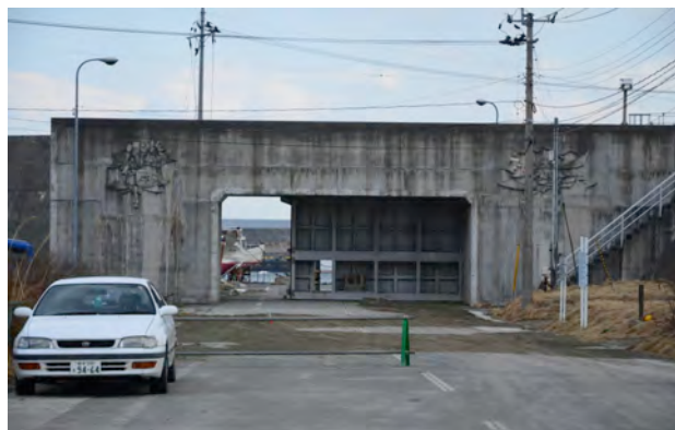
種市市街を護った高さ 12 m の防潮堤。
