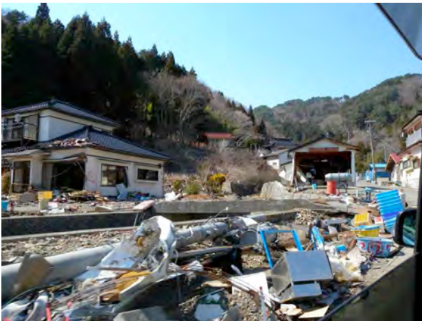
防潮堤から約 300m 程離れた集落の被災
