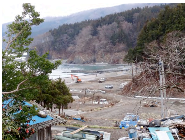
堤防は大部分が決壊していた
