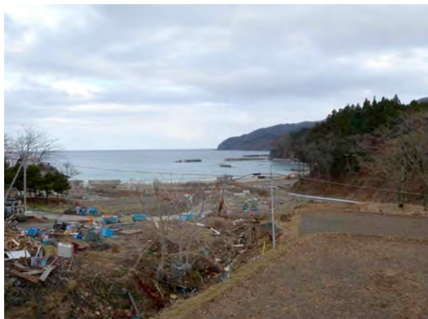
倒壊した作業小屋とがれき
