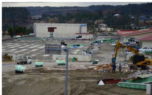
鉄筋コンクリート造の栽培漁業センターの建物は残ったが、ワカメ・アワビ等の育苗施設が全壊
