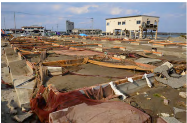
木造漁業施設は土台上から跡形もなく流失した
