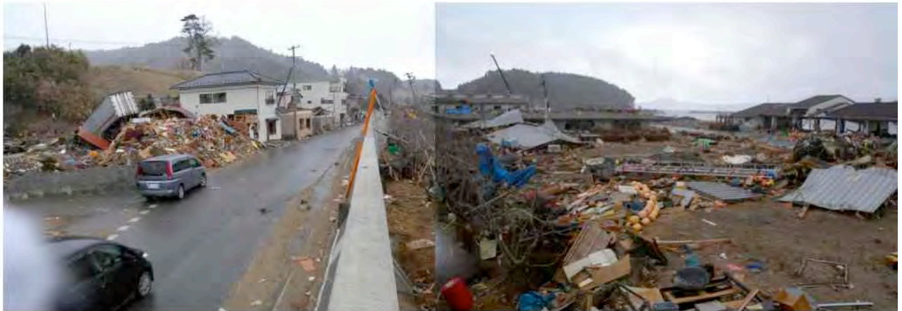
堤内の道路沿いと港湾部の被災状況 *南方向を撮影
