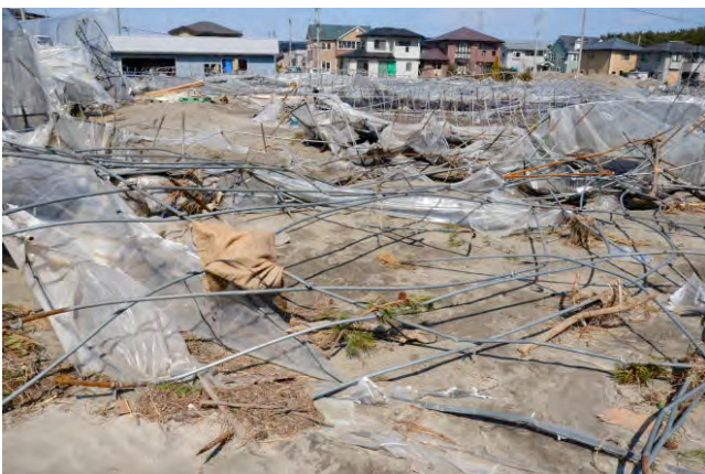
津浪により倒壊したビニールハウス (八戸市市川字橋向)
