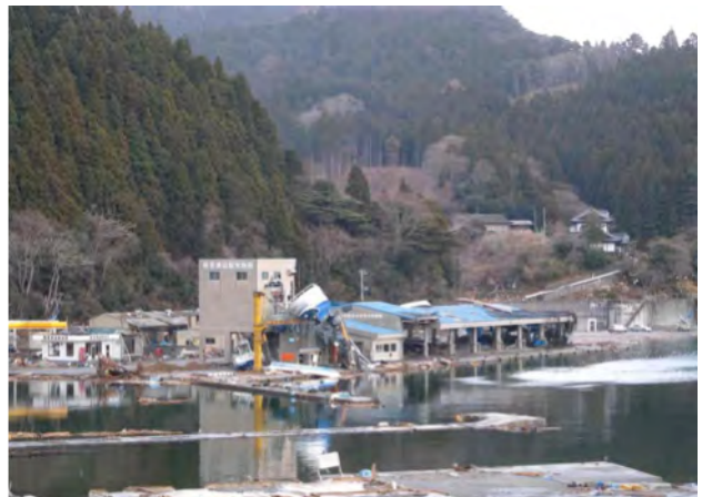
漁協製氷施設には船が打ち上げられていた
