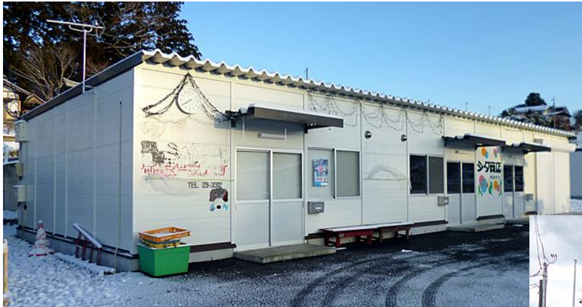
←仮設店舗・工場3連棟
