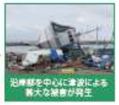
写真で見る被害状況
