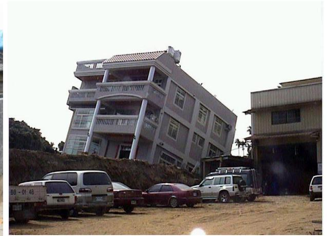
1999年台湾集集地震の断層変位で傾斜と修復したRC[建物(久田)
