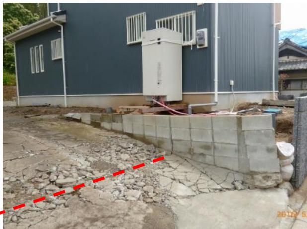
2016熊本地震の地表地震断層の断層変位に耐えた木造建物(久田)
