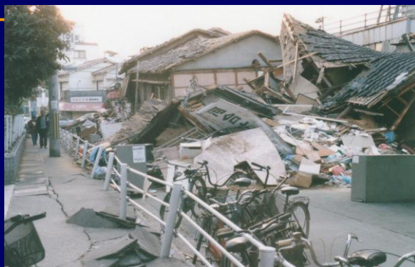
道路を塞ぐ倒壊家屋 1995年阪神淡路大震災
