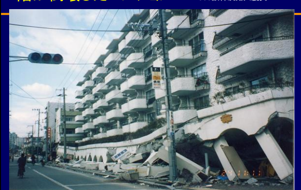
1階が倒壊したマンション 1995阪神淡路大震災
