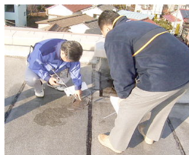
不具合箇所をしっかりと確認
