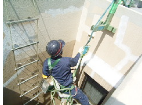
足場やゴンドラを使つての修繕工事
