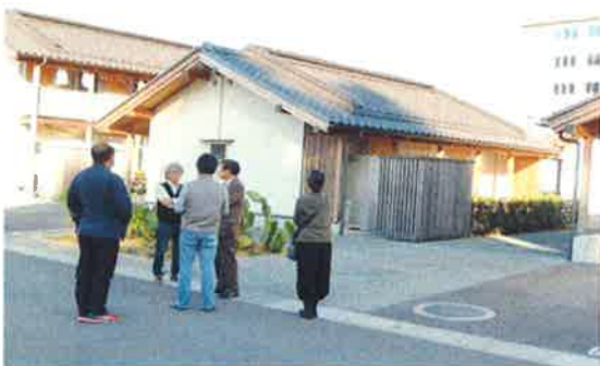
写真 4. 土佐町町営住宅 舞田団地
