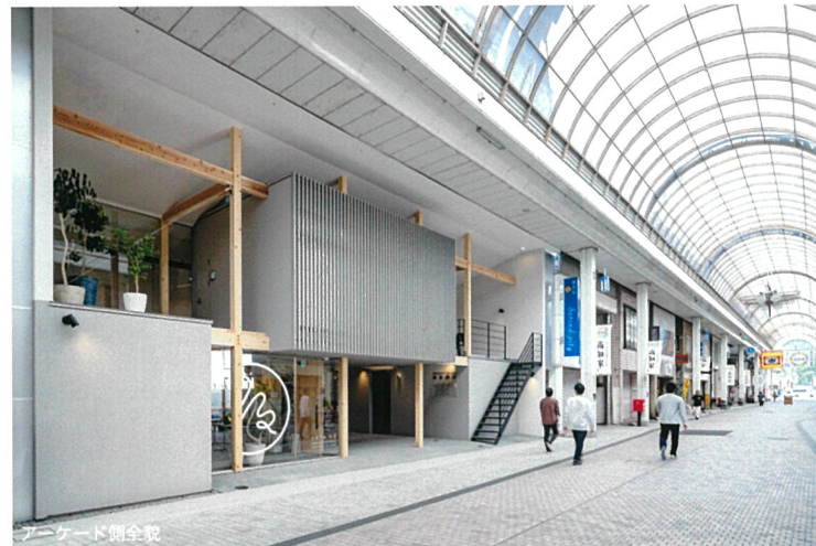
アーケード側全景
