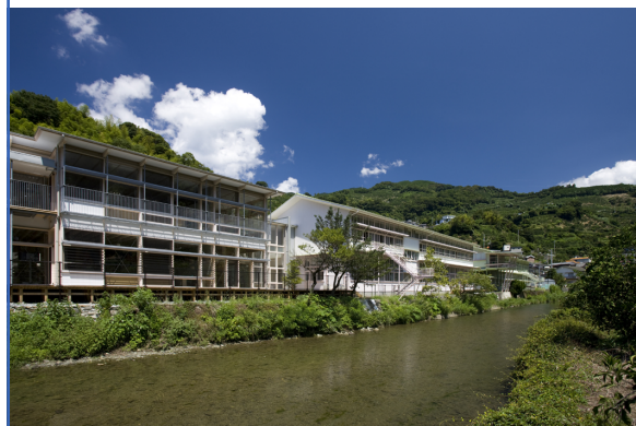
建設当初の写真
