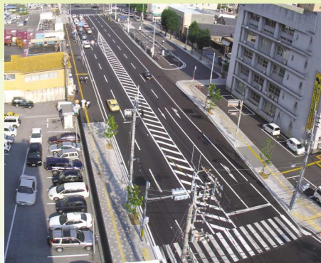
3 道路拡幅と電線類の地中化
