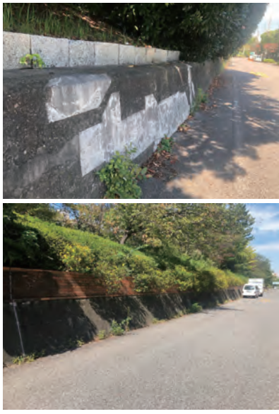
型枠となった旧葛西海岸堤防
