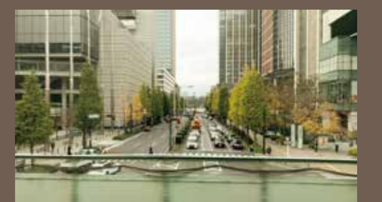
道と道の立体交差・俯瞰
