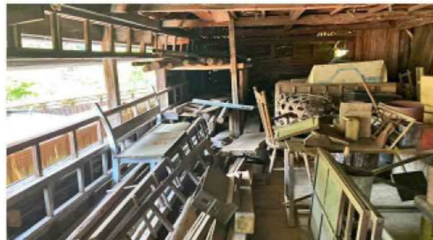
①厩の現状写真 ・大量の道具が置かれ奥まで進むことができない。 ・所々、床板がはがれている。 ・雨風にさらされ汚れが目立つ。
