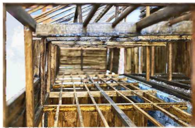
②厩の軸組模型写真 ・計画調査から現状の厩の軸組模型を複製。 ・部材の色や汚れ具合も現状に合わせて複製。 ・柱や梁が腐り落ちている箇所を再現。
