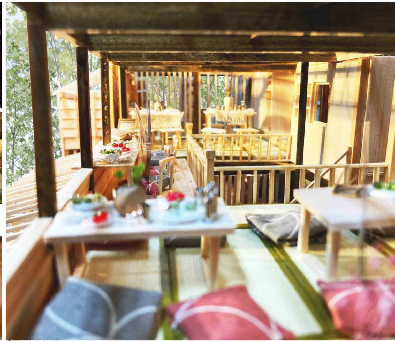
③厩の改修後写真 ・改修後は「学びのカフェ」として地域の人々をつなぐ場所になる。 ・濃い色の材木は既存の部材、薄い色の材木は新しく取り付けた部材になっている。 ・既存の部材を活かすことで厩として使われていた歴史を受け継ぐ。
