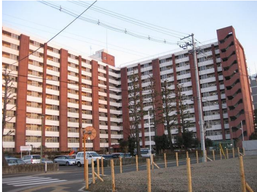
写真 2 5 仙台市太白区長町の郡山市営住宅
