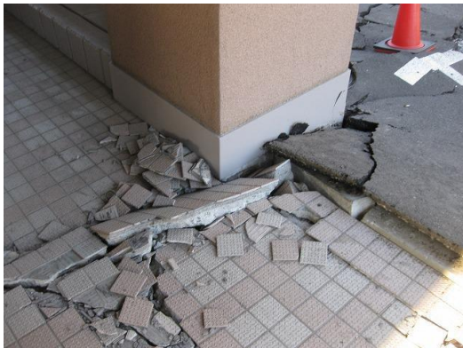
写真19 柱脚部周辺の状況
