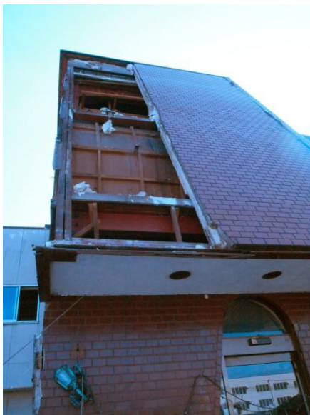
写真1 4 若林区卸町の鉄骨造建物の外壁の落下
