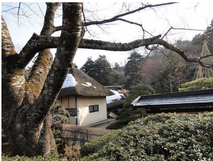
写真 13 有備館（写真奥の建物）の全壊
