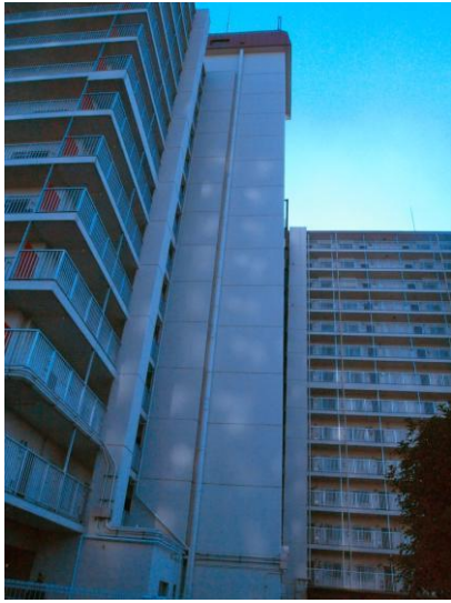
写真18 2棟のE x p J部を真横から撮影（3月12日（左）と3月16日（右））
