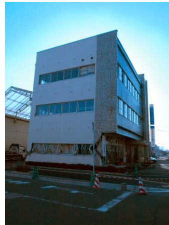
写真1 3 若林区卸町3丁目のRC造3階建の崩壊
