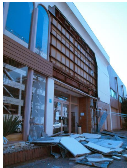
写真1 4 若林区卸町の鉄骨造建物の外壁の落下
