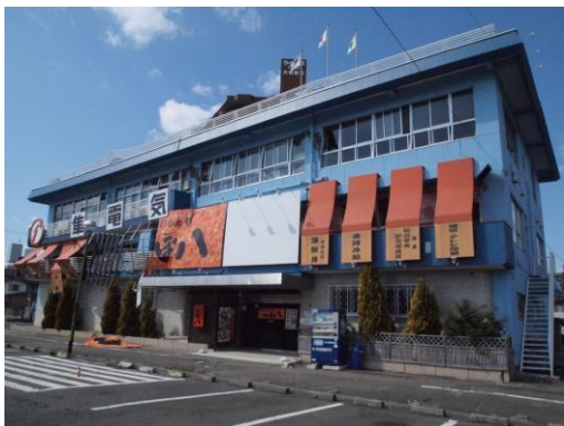
写真6 大和町5丁目の3階建てRC造の2階部分の崩壊
