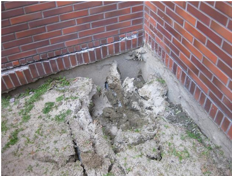
写真 11 11 階建て RC ホテルの基礎と地盤の境界部分
