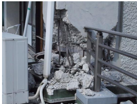
写真4 東側妻壁単側の外柱の被害状河
