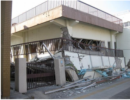
写真1 2 若林区卸町2丁目のRC造2階建て建物の崩壊
