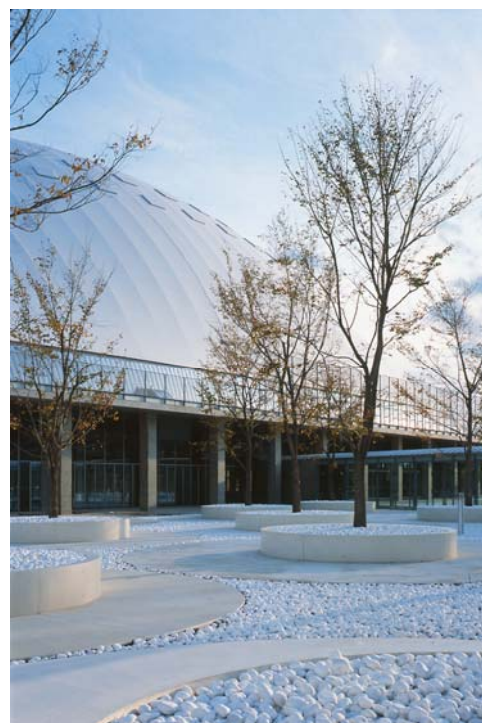
しもきた克雪ドーム
