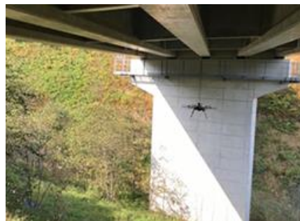
ドローンによる点検
