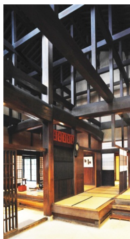
図4-5 重要文化財吉島家住宅(高山) 明治40年(1907) 小屋組
