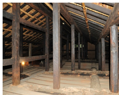
図4-3 重要文化財佐々木家住宅(隠岐の島) 天保7年(1836) 梁組・小屋組
