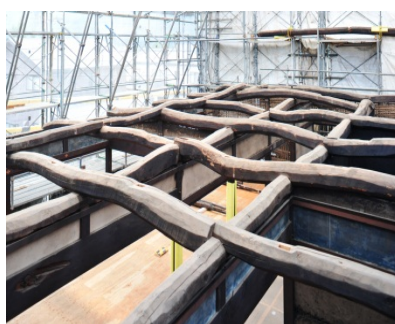
図4-2 重要文化財小野家住宅(塩尻) 嘉永3年(1850) 梁組
