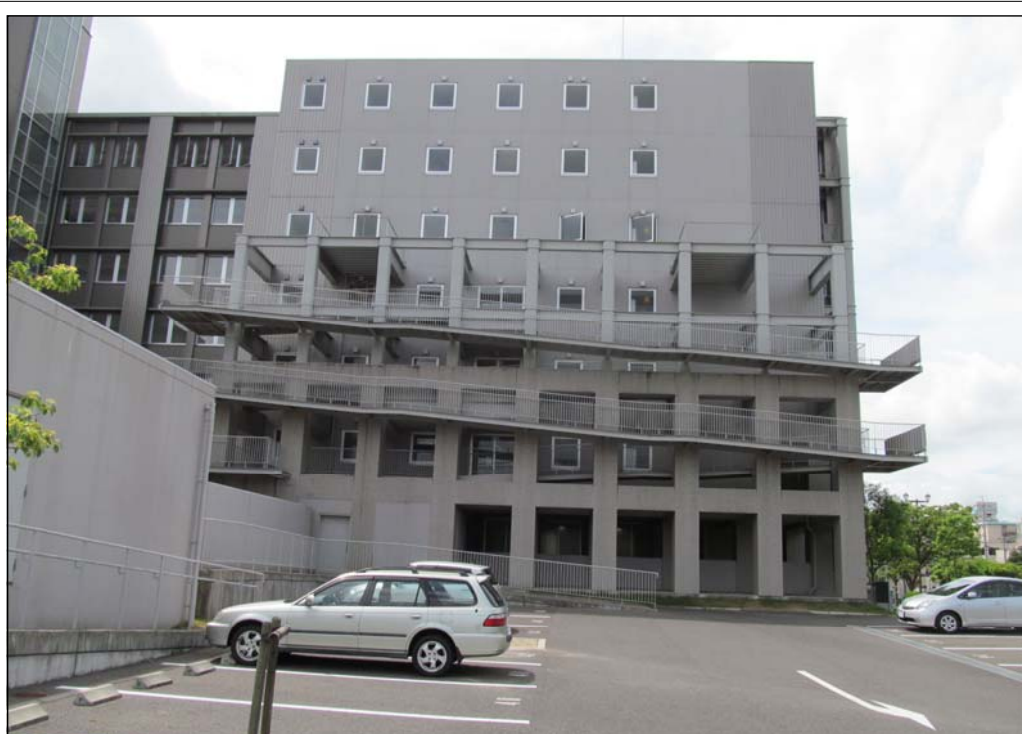
きらめきプラザ(旧国立岡山病院)[竹中工務店 2005年]
