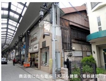
商店街にたち並ぶ「天ぷら建築（看板建築）」
