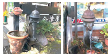
道沿いに設置された共同水道「竜頭」(蛇体鉄栓式共用栓)」
