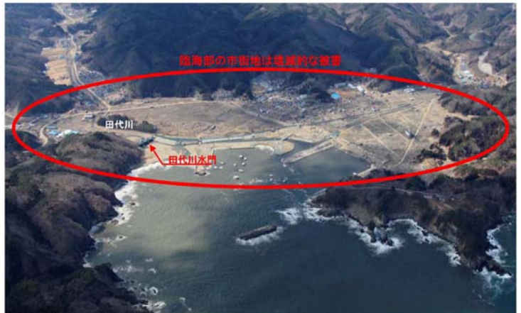
写真 2.7-2 被災後の田老地区市街地
