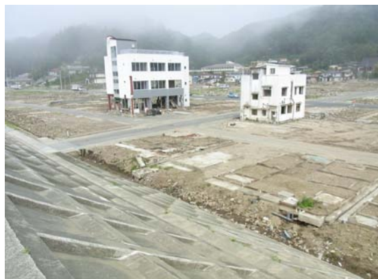
写真 2.7-6 防潮堤内側の被災状況
