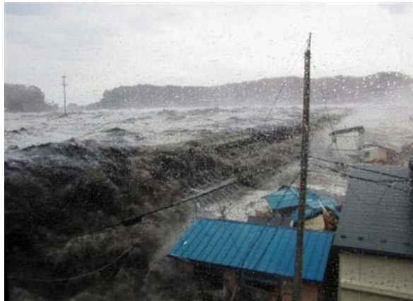
写真 2.7-3 津波の越流状況(漁協ビル前)
