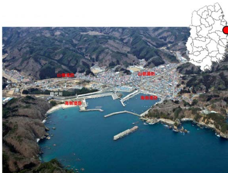
写真 2.7-1 被災前の田老地区市街地
