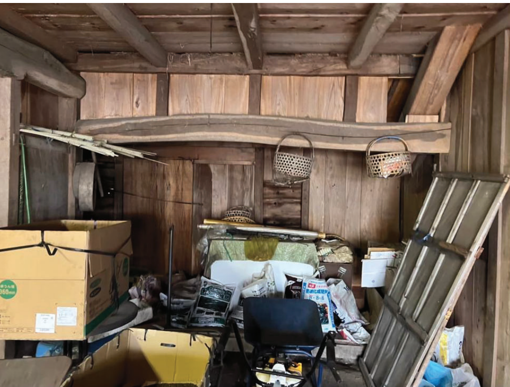
93年前の建物 解体時
